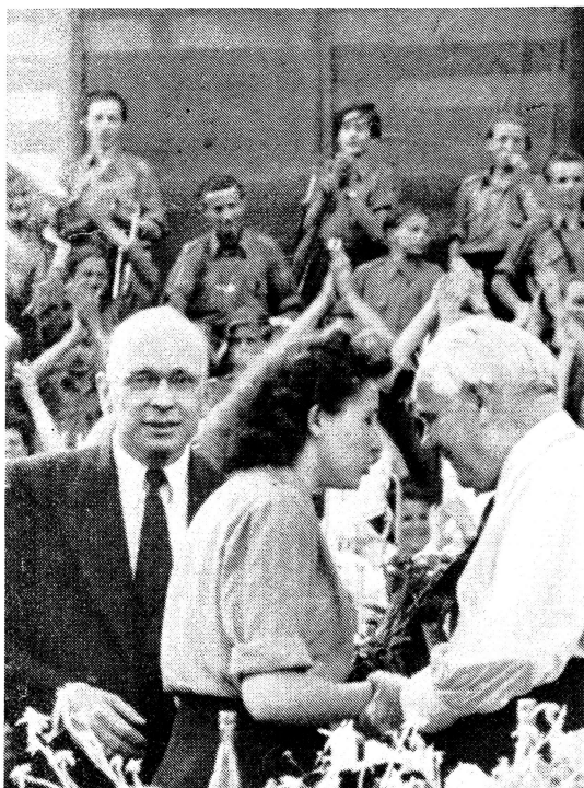
Historische Fotos — Dokumente im Traditionskabinett der BPO im Chemiefaserkombinat „Wilhelm Pieck“ in Schwarza. U.B.z. Wilhelm Pieck am 16. 6. 1350 im damaligen Thüringer Kunstfaserwerk.
