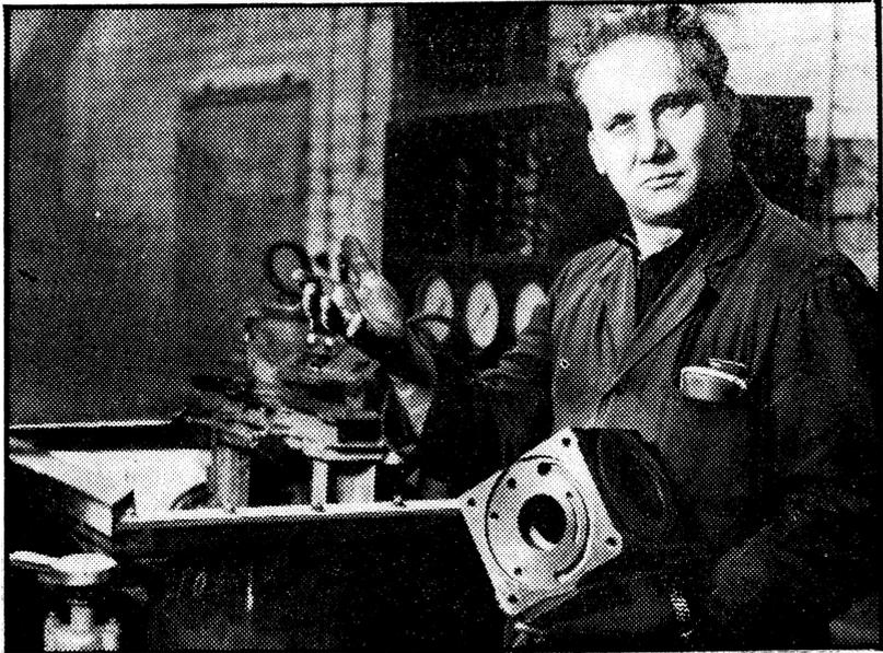
O bermeister Genosse Wolff: „Diese Gußteile für Steuerventile erhalten wir aus dem VEB Leipziger Eisen- und Stahlwerke. Die Hälfte davon sind Materialausschuß. Durch ein Verdichtungsverfahren können 90 Prozent der Gußteile wieder verwendet werden. Doch die Unterbrechung des Arbeitsflusses und der absolute Ausschuß mindern den Nutzeffekt der modernen Technik. Wir fordern von der Parteiorganisation der LES: Macht Schluß mit dieser Schluderarbeit!“
