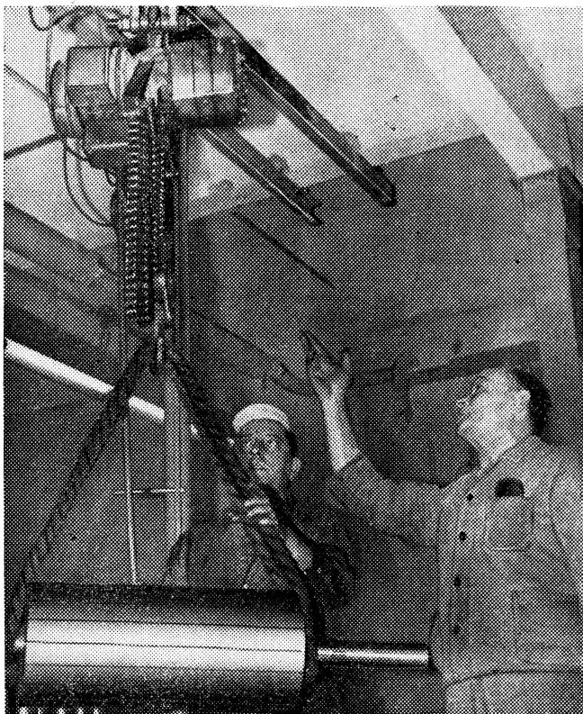
Die neue Hebevorrichtung erleichtert dem Kollegen Philipp die Arbeit und trägt wesentlich zur Steigerung der Arbeitsproduktivität in der Schleiferei bei. Genosse Scharfe, Gewerkschaftsvertrauensmann der Brigade, widmet der Verwirklichung der Arbeitervorschläge besondere Aufmerksamkeit
